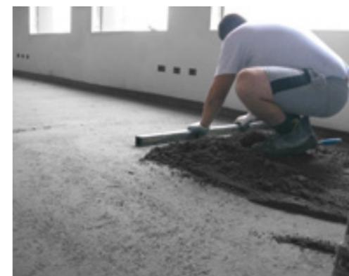
En cas de brusques variations d'épaisseur, dues au passage de tuyaux, canalisations, etc., il convient d'insérer un treillis métallique à maille hexagonale dans la chape, afin de la renforcer et de limiter la formation de fissures. En tous cas, l'épaisseur de chape au-dessus des tuyaux ne doit pas être inférieure à 2 cm.
