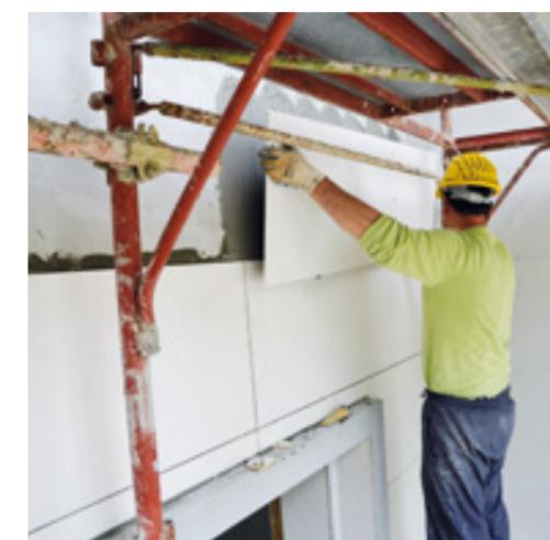
**Pose et jointoiement des dalles fines**
