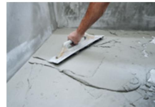
Pour une finition plus lisse de la surface, utiliser une taloche en éponge lorsque le produit commence à prendre et qu'il a suffisamment durci. Une éventuelle couche de rectification peut être réalisée environ 3 heures après l'application de la première couche.
