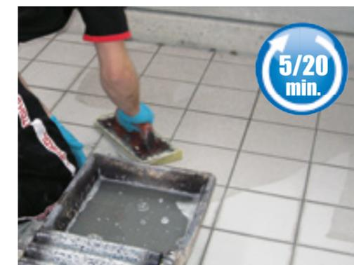
**Préparation et application des matériaux de remplissage des joints**
