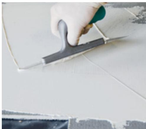
2 - Réaliser un rasage d'au moins 1 mm d'épaisseur. Lorsque le produit est prêt à être ouvert au passage (environ 24 heures) coller les carreaux utilisant la spatule dentée.
