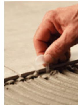
Étaler l'adhésif et insérer le support sous le carreau sur les quatre côtés. Positionner un ou plusieurs supports sur chaque côté selon le côté des carreaux. Positionner les carreaux et taper avec le marteau en caoutchouc.
