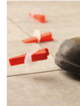
Attendre le durcissement de l'adhésif et retirer le coin et la partie qui dépasse du support en tapant, dans le sens de la ligne de fugue, avec le marteau en caoutchouc ou simplement avec le pied.
