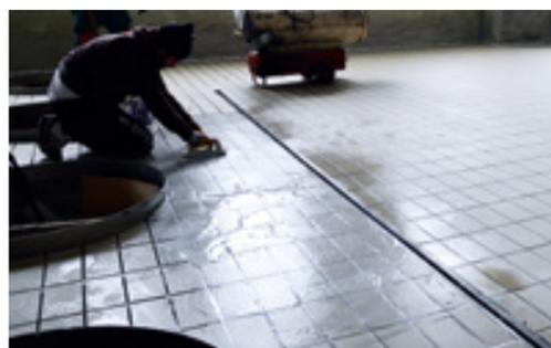
Ensuite effectuer un deuxième passage en utilisant une éponge rigide en sweepex (Art. 128/G) pour obtenir une surface lisse et fermée, en retirant complètement le produit des carreaux, sans vider les joints et en séchant l'excès d'eau.
